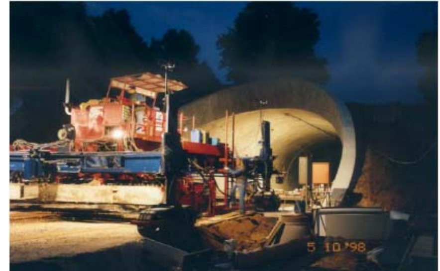
Straßenfertiger für die Betonfahrbahn im Tunnel
