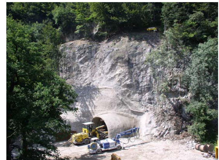
Anschlag des Zugangsstollens mit Felssicherung Luftbogenstrecke
