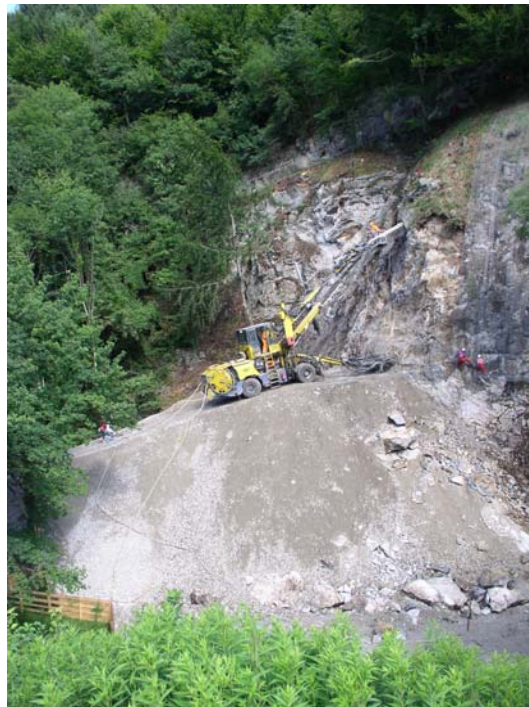
Böschungssicherung im Voreinschnitt
