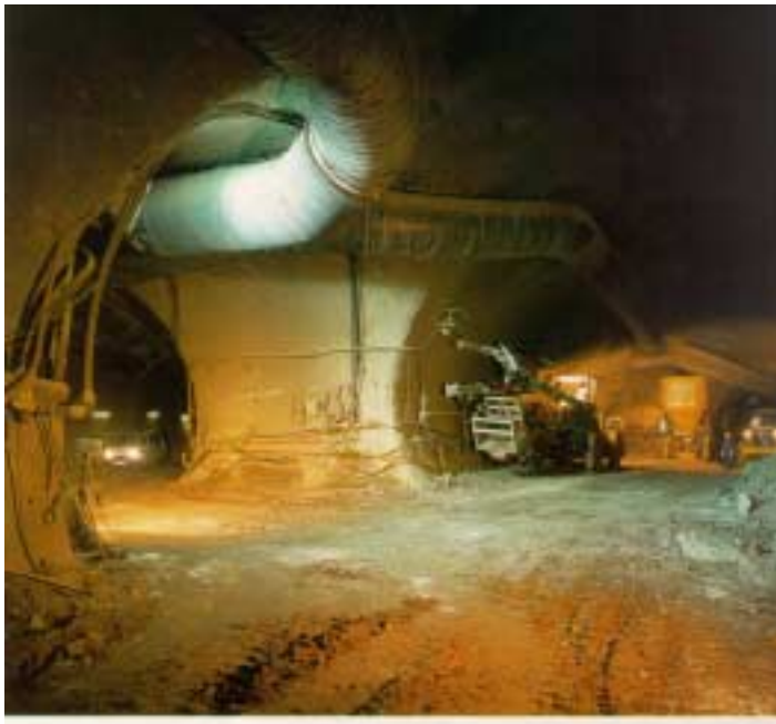
Kreuzung Zugangsstollen – Haupttunnel mit Blick in die Aufweitung.
