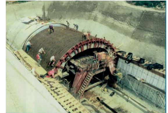
Riedbergtunnel: Halboffene Bauweise
