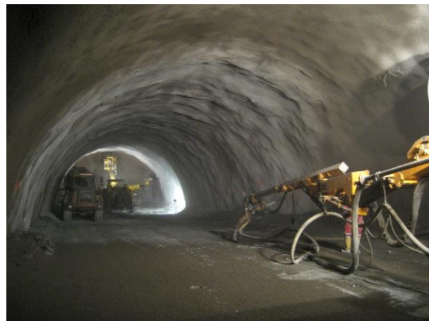
Kalottenvortrieb nach NATM
