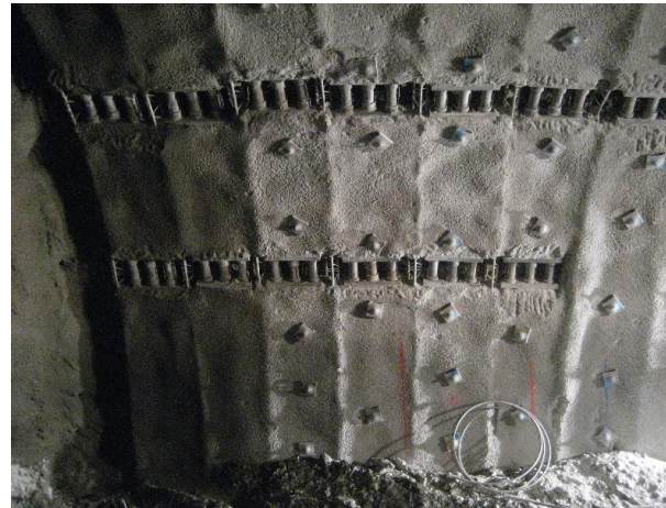
Einbau von Stauchelementen zur Entlastung der Spritzbetonschale in stark druckhaftem Gebirge
