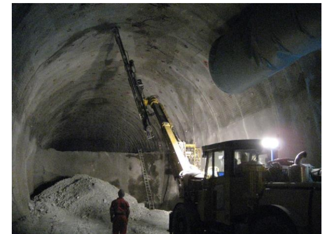
Nachlaufender Strossenvortrieb
